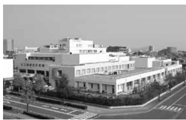
広南病院外観
